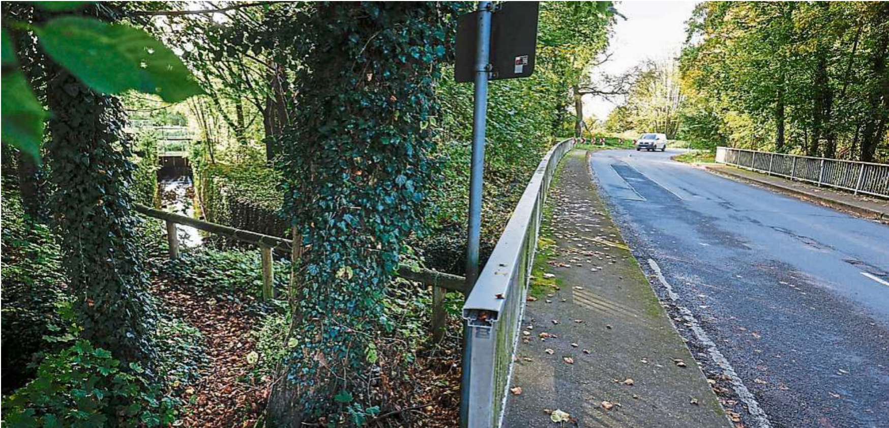
Die Brücke über den Katzengraben zwischen Groß- und Klein-Zimmern wird nächstes Jahr abgerissen.
